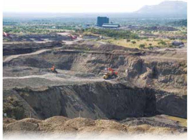
Instalações da AMCOL para produção e mineração de Hevi-Sand® República da África do Sul
